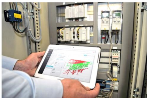
Technische kijkrichting voor onderhoudsbedrijven
